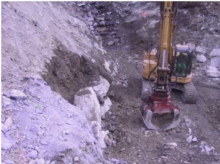
17.11.2011: Ufersicherung im Geschiebesammler mit Blöcken
