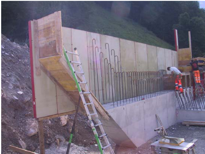
2.9.2011: Aufgehende Wandschalung und Leibungsschalung für Durchlassöffnung werden erstellt.
