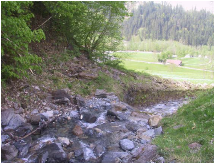
29.4.2011: Blick abwärts auf das obere Ende der gemauerten Bachschale.
