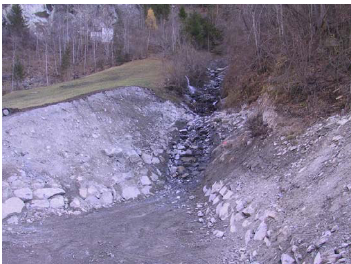
23.11.2011: Blick aufwärts in den fertig erstellten Geschiebesammler.
