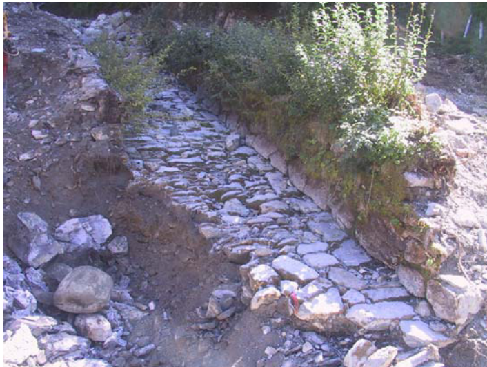
16.9.2011: Der Aushub für den Geschiebesammler ist im Gang.
