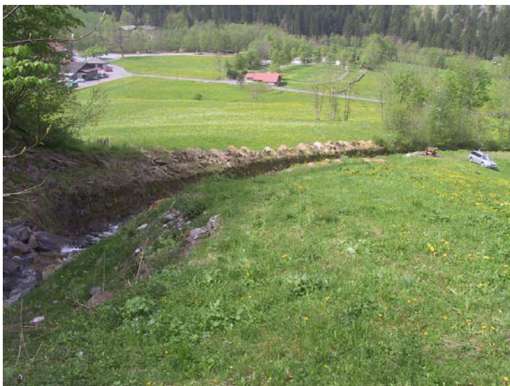
29.4.2011: Blick auf das Areal des zukünftigen Geschiebesammlers.
