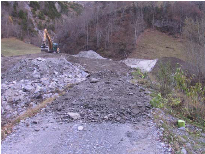
25.11.2011: Die Zufahrt zum Geschiebesammler wird angehoben und gekoffert.
