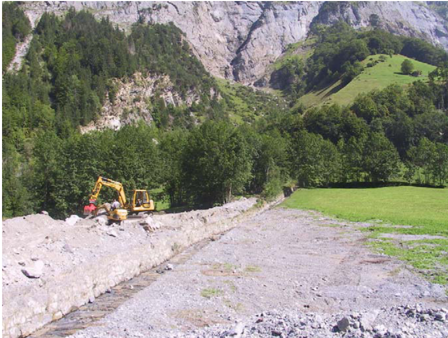
8.9.2004: Die Aufräumarbeiten sind schon weit vorangeschritten.
