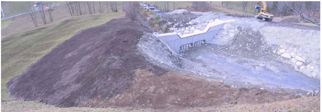
25.11.2011: Blick in den fertig erstellten Geschiebesammler.
