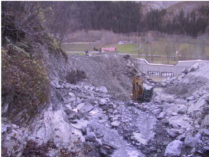
14.11.2011: Blick von der Einlauframpe in den Geschiebesammler, wo die Ufersicherung mit Blöcken erstellt wird.
