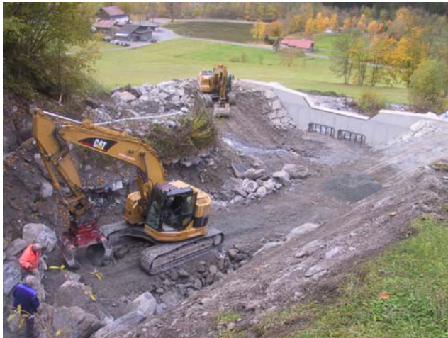
1.11.2011: Die Einlauframpe in den Geschiebesammler in Arbeit.
