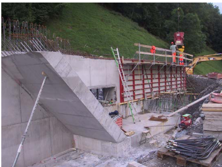
14.9.2011: Weitere Maueretappe der Abschluss-Sperre wird geschalt.
