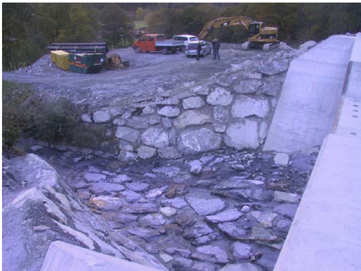
17.10.2011: Die Abschluss-Sperre ist erstellt und der unterhalb liegende Einlauftrichter ebenfalls.
