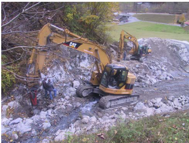
4.11.2011: Felsabtrag für die Bypass-Leitung am linken Ufer neben der Einlauframpe.
