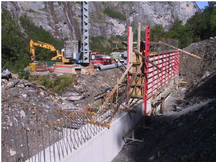
6.9.2011: Aufgehender Mauerteil der Abschluss-Sperre bereit zum Betonieren.
