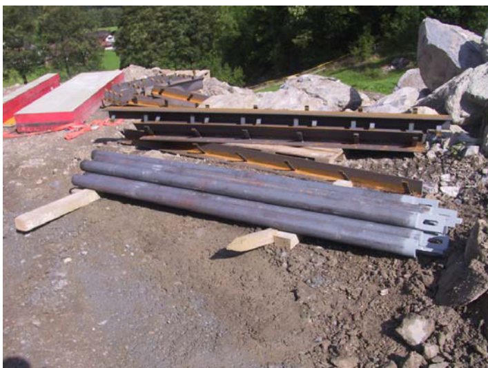
2.9.2011: Die Vollstahlstäbe für den Geschieberechen liegen bereit, darüber die Kantenschutzeisen.
