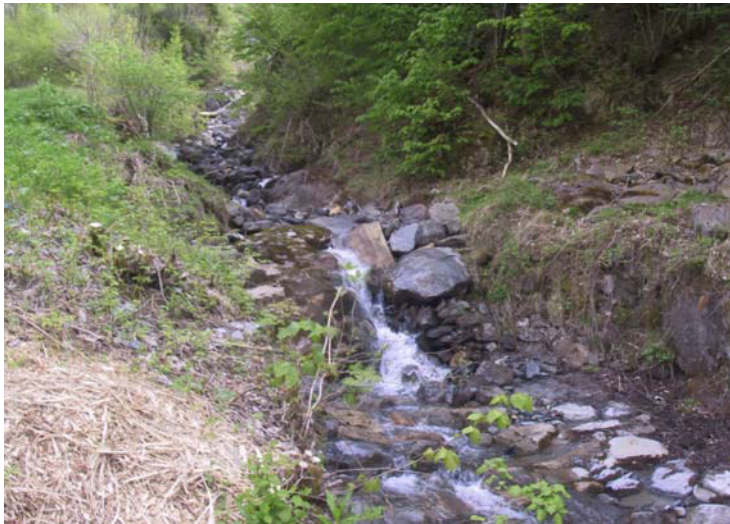
29.4.2011: Einlauf des Mattenbachs in die gemauerte Bachschale.
