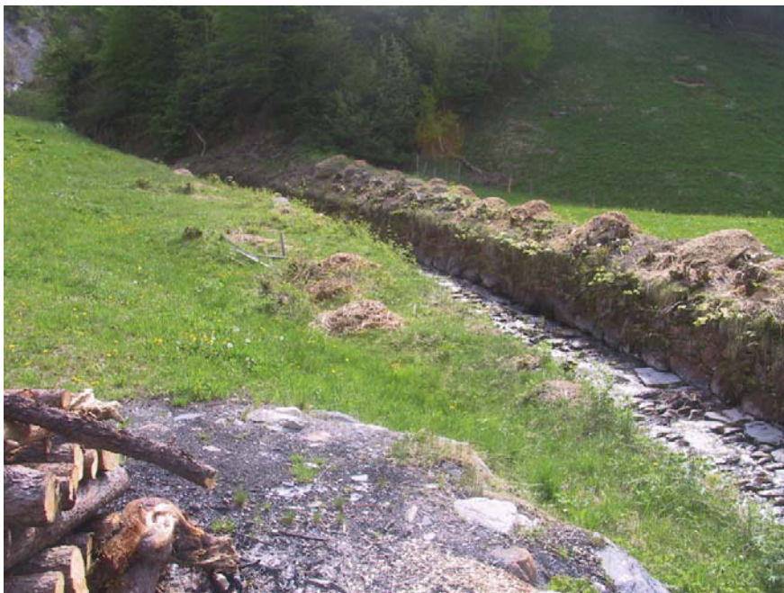
29.4.2011: Die zukünftige Abschluss-Sperre liegt bei dem eingesteckten Holzpfahl.
