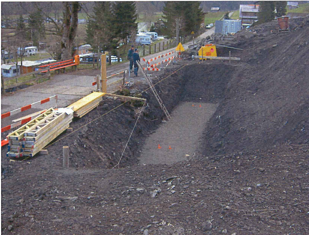
Aushub für die Geschiebesperre (November 2007)
