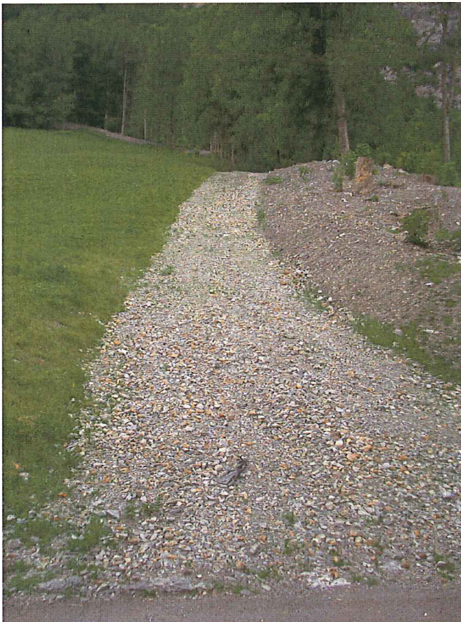
Nach Realisierung: Südliche Abgrenzung des Geschiebesammlers mit Zufahrtsweg
