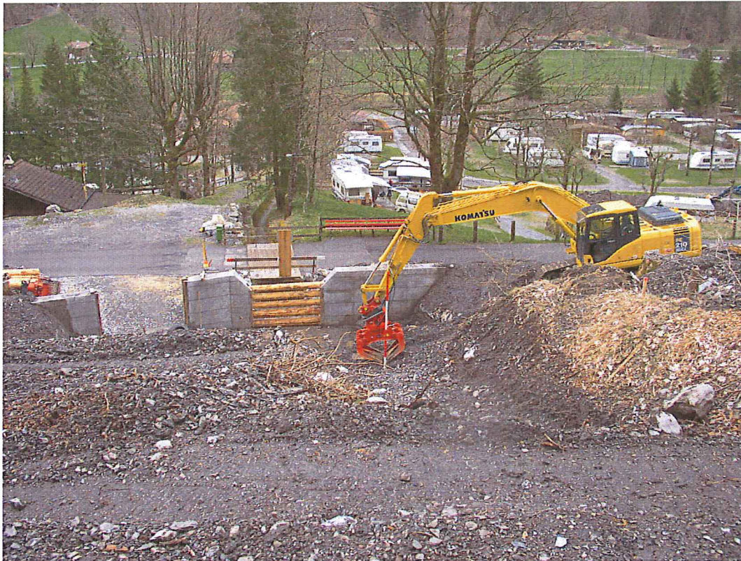
Aushub für den Geschiebesammler (Februar-März 2008)
