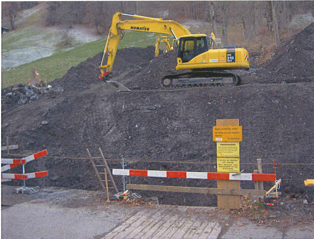
Voraushub des Geschiebesammlers (November 2007)
