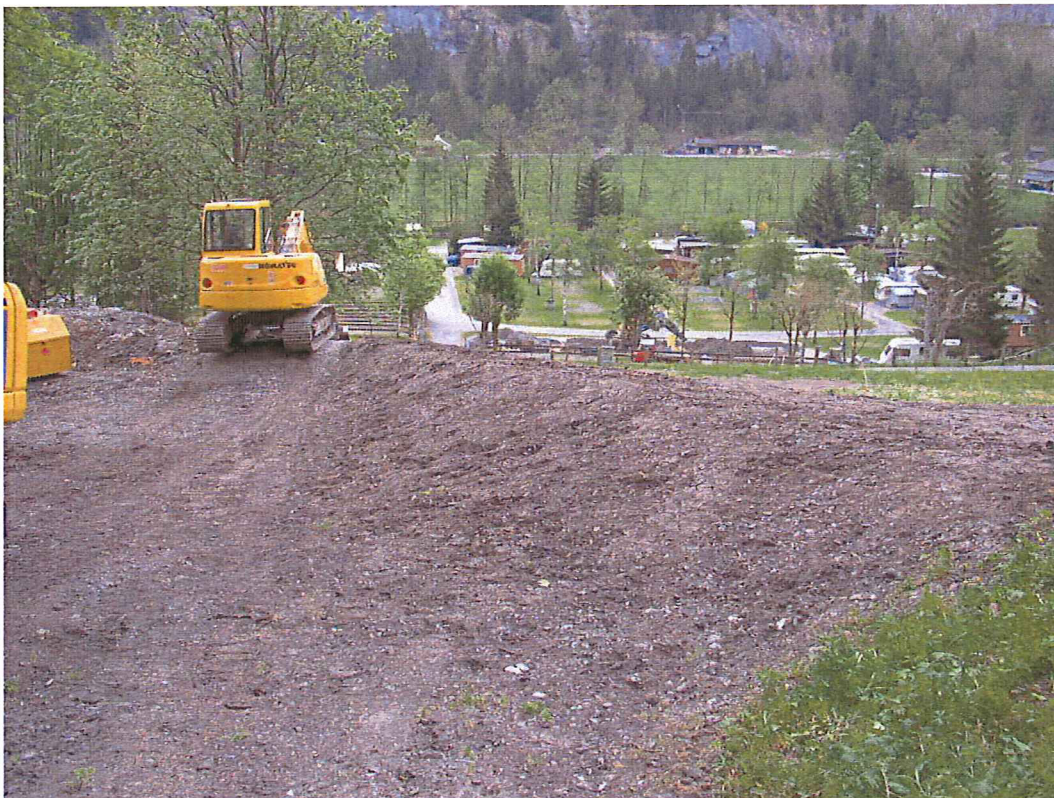
Fertigungsarbeiten am unteren Leitdamm (Mai 2008)
