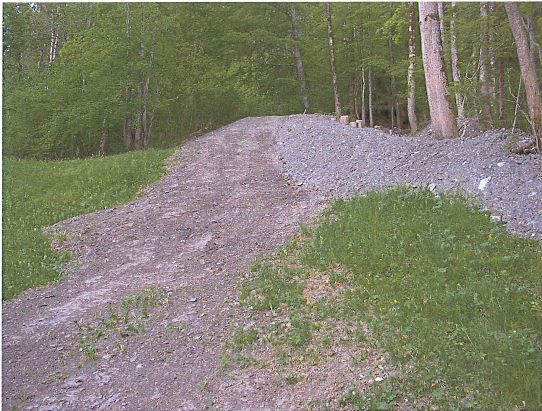
Oberer Leitdamm (Mai 2008)
