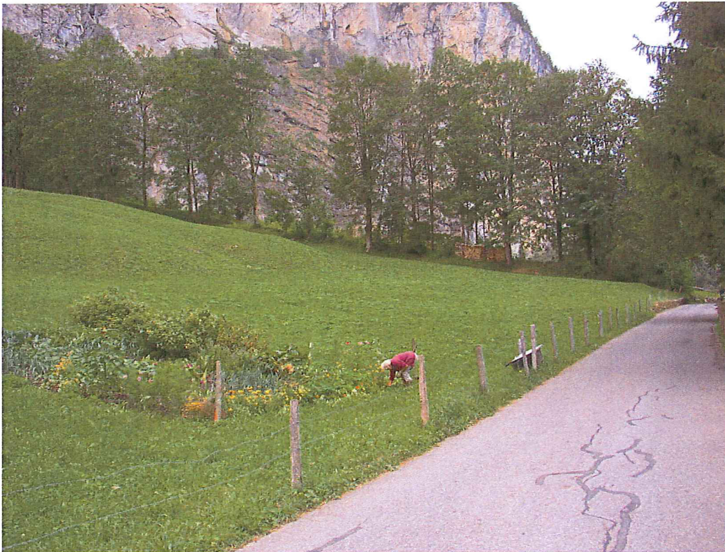
Vor Realisierung: Gesamtansicht von Süden auf das Louweligräßli vor den Bauarbeiten
