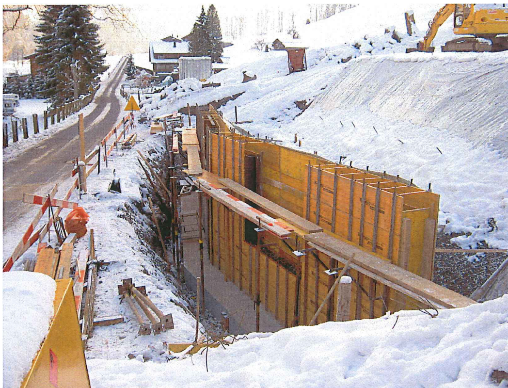
Schalung und Armierung der Geschiebemauer (Dezember 2007)
