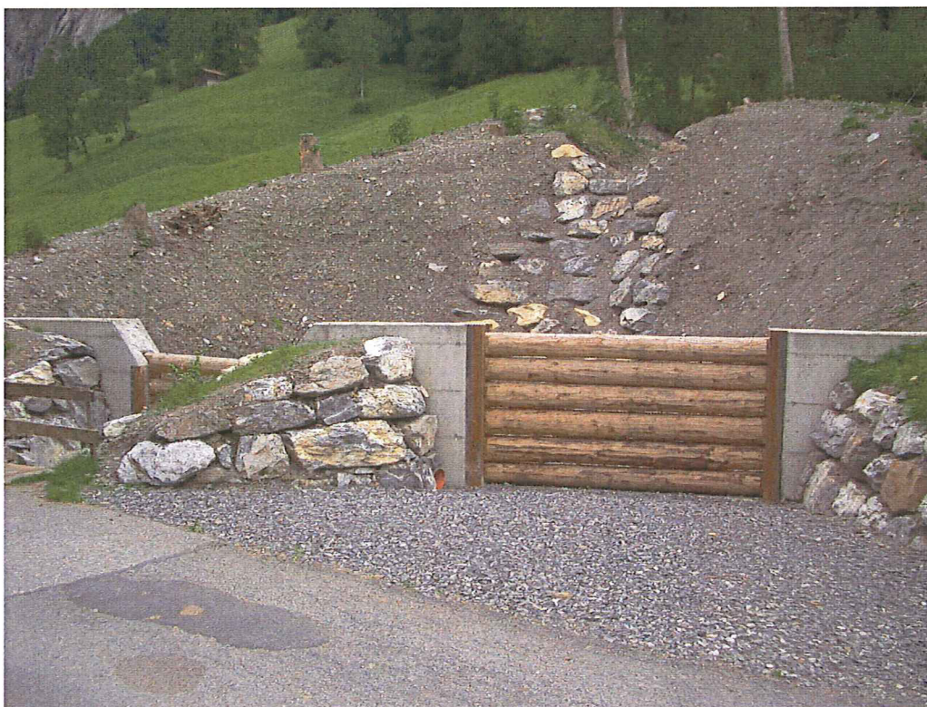
Nach Realisierung: Geschiebesammler mit Geschiebesperre nach Fertigstellung im Sommer 2008
