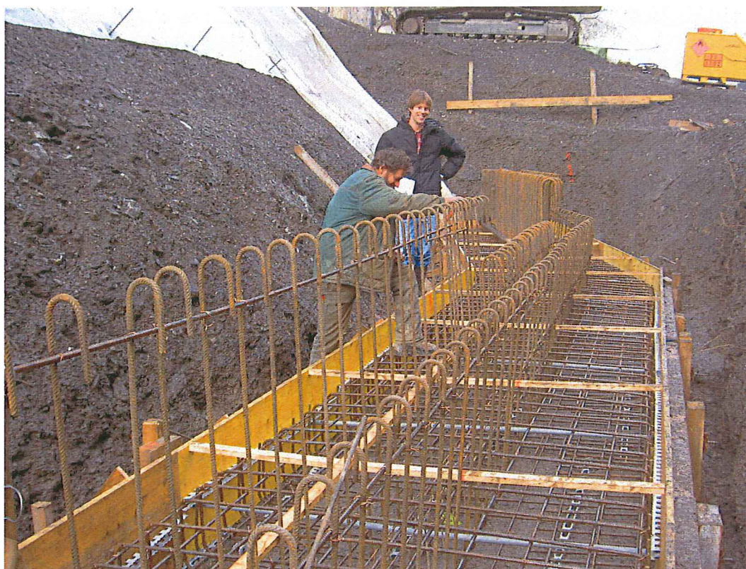
Armierung des Fundaments (Dezember 2007)
