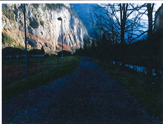
Abbildung 38: Damm und Unterhaltsweg Sportzentrum
