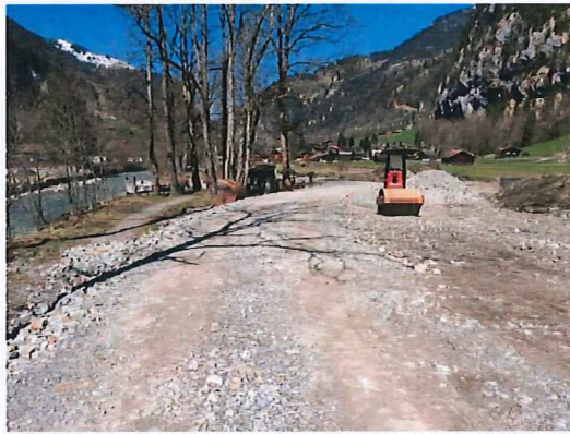
Abbildung 22: Dammbau Höhe Heliport
