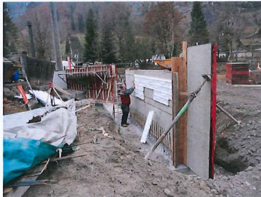
Abbildung 14: Hochwasserschutzmauer Chalet Jungfrau
