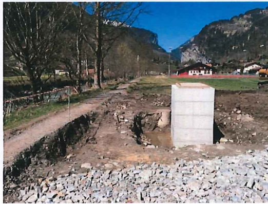
Abbildung 16: Dammbau UW Chalet Jungfrau Blick Richtung Norden
