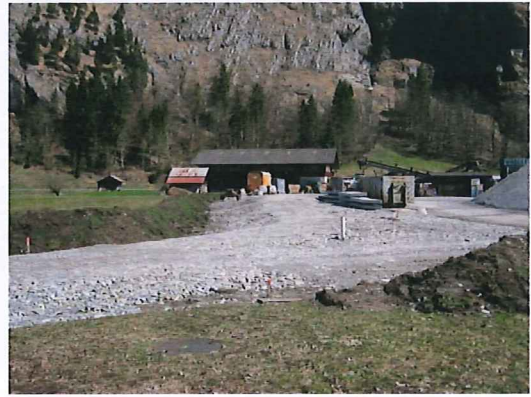
Abbildung 17: Dammaufbau OW Heliport
