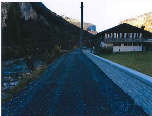
Abbildung 34: Hochwasserschutzmauer
