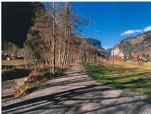
Abbildung 30: Unterhaltsweg im Bereich des Heliport
