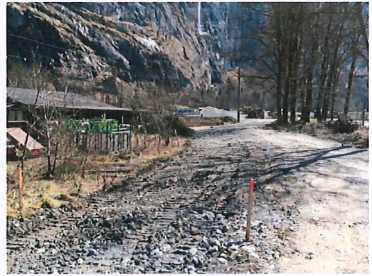
Abbildung 23: Dammbau Höhe Heliport
