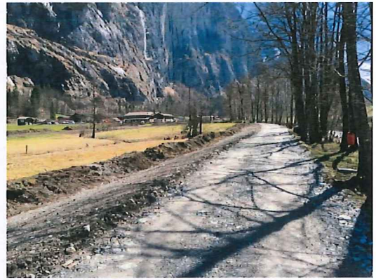
Abbildung 21: Unterhaltsweg in der Weid
