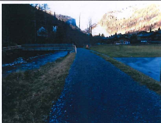
Abbildung 40: Damm und Unterhaltsweg Sportzentrum
