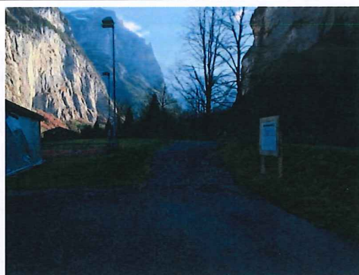
Abbildung 39: Damm und Unterhaltsweg Sportzentrum
