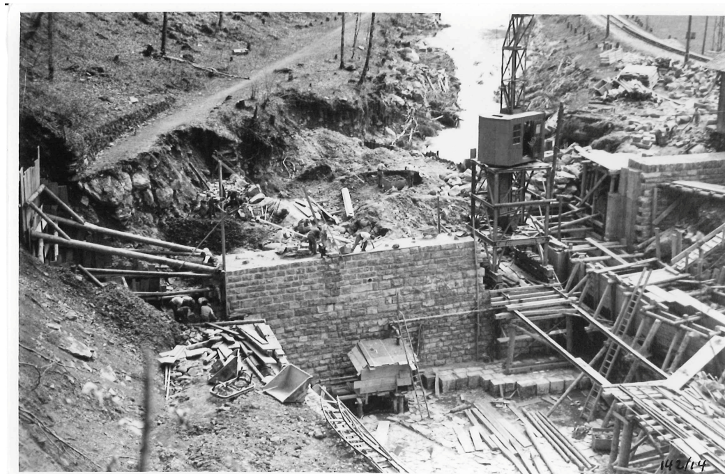
Abbildung 5: Bau der Hauptsperre Sandweidli, 1934. Blick gegen die Fliessrichtung. Aus Fotoarchiv Schwellenkorporation Lauterbrunnen.
