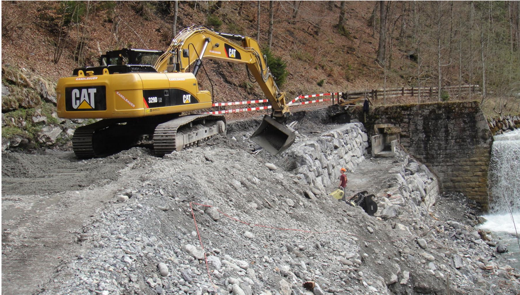
Abbildung 4: Instandstellung der rechten Böschung und des Fischpasses nach dem HW-Ereignis 2011. Foto: Mätzener & Wyss AG.
