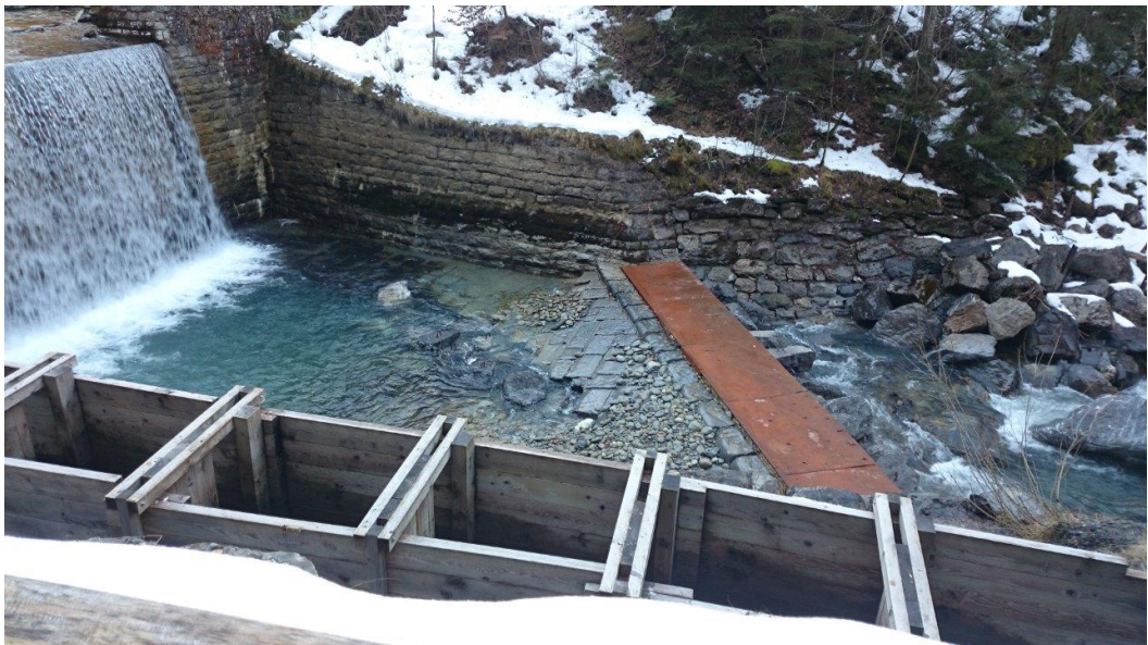
Abbildung 3: Provisorische Sicherung der Vorsperre mit grossen Blöcken. Foto: Ralf Schai
