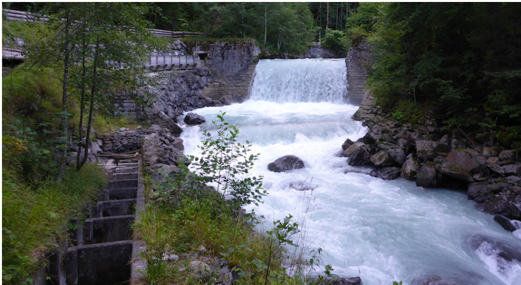
Abbildung 6: Bestehendes Sperrensystem (Hauptsperre und Vorsperre) in der Weissen Lutschine bei Sandweidli. Aufnahme vom August 2015.
