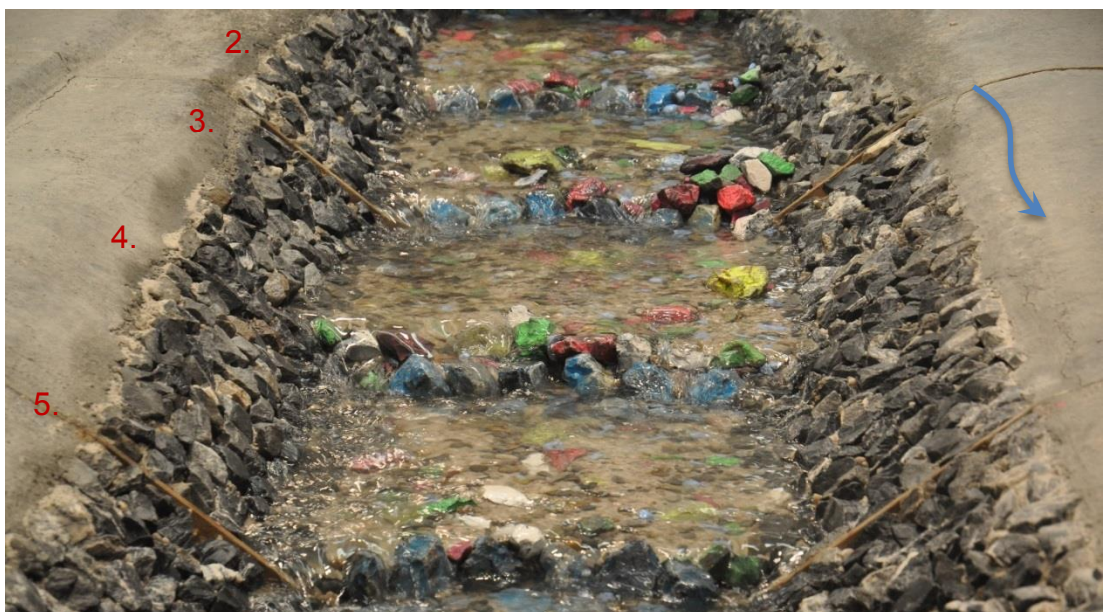
Abbildung 67: Stufe Nr. 2 - 5 bei Niederwasser nach der HQ 100 Ganglinie.
