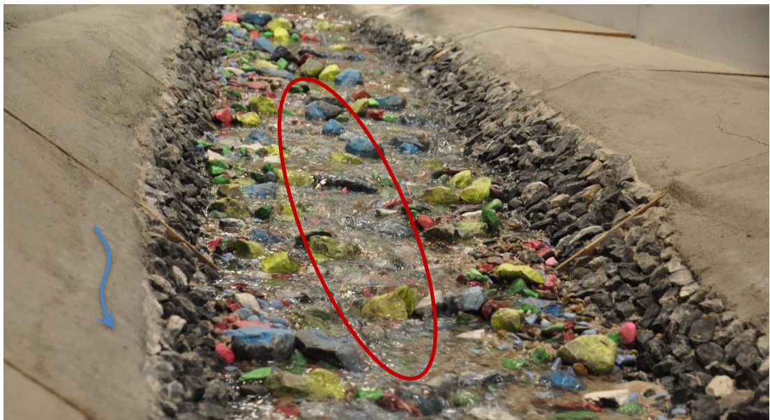
Abbildung 34: Gerinne bei Niedrigwasser im oberen Bereich des Projektperimeters nach Belastung mit der HQ 100 -Ganglinie. Die Strömungskonzentration ist rot markiert.
