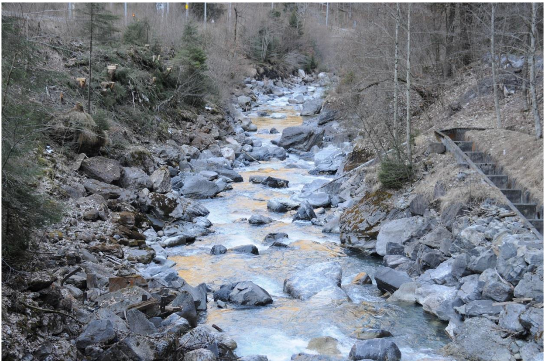
Abbildung 6: Blick über die Sperre in Fließrichtung mit Blick auf das bestehende Stufen-Becken-Gerinne.
