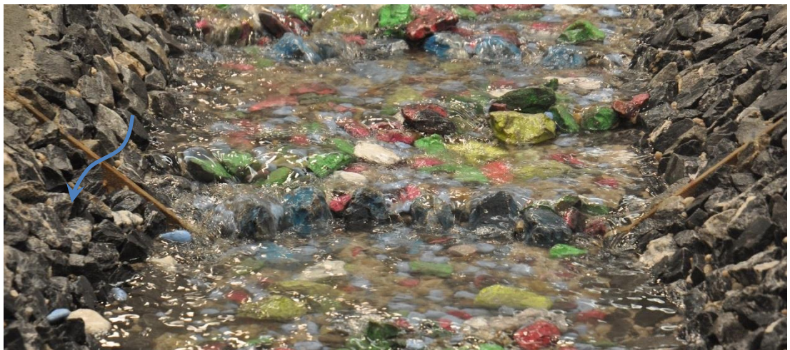
Abbildung 65: Stufe 5 beim Niederwasser nach HQ_{30} .
