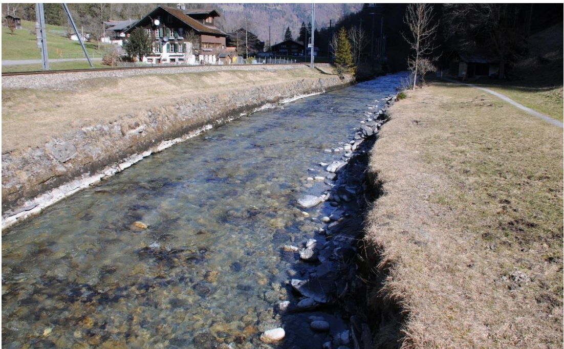
Abbildung 4: Blick in Fließrichtung auf bestehendes Gerinne oberhalb der Sperr.
