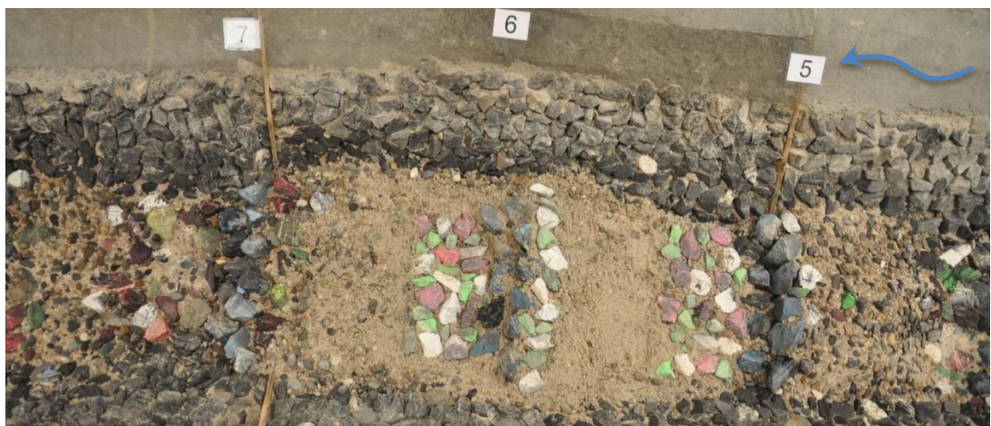
Abbildung 84: Stufen Nr. 5 bis 7 nach Reparatur.
