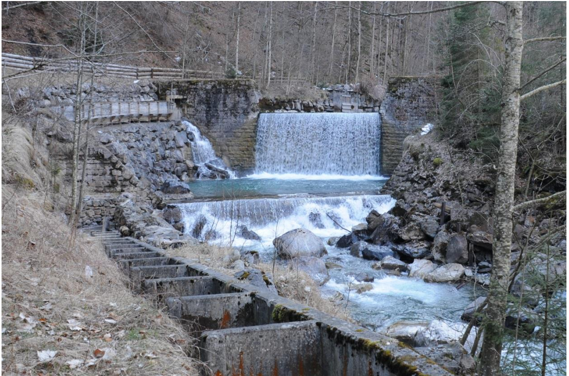
Abbildung 5: Blick gegen Fließrichtung auf die zu ersetzende Sperre mit Gegensperre und Fischtreppe im Vordergrund.
