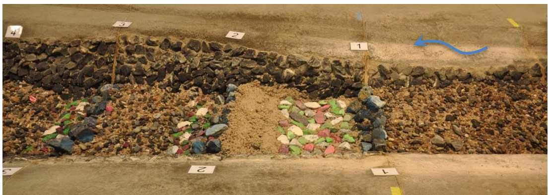
Abbildung 82: Neubau des Kolkschutzes (Kolkwanne) nach Stufe Nr. 1 nach HQ_{30} .
