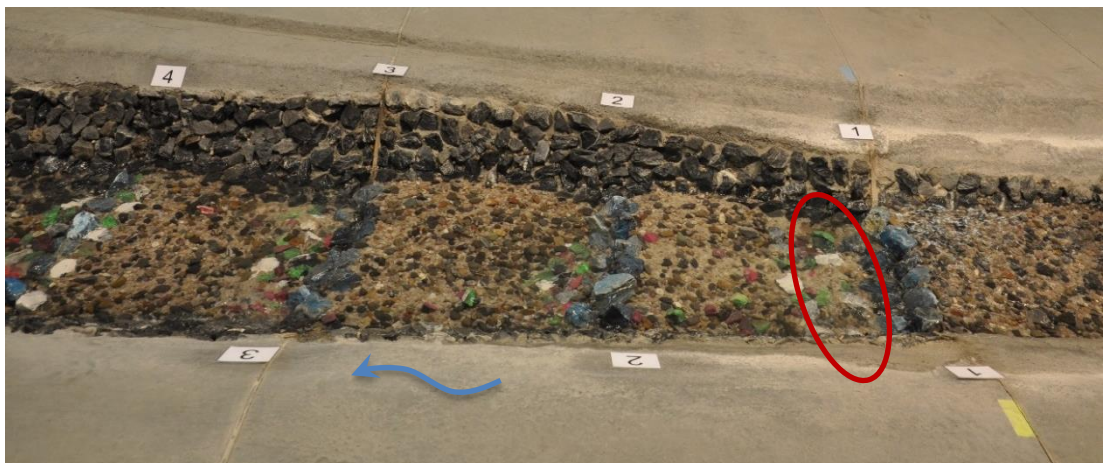
Abbildung 80: Stufen Nr. 1 bis 4 bei Niederwasser nach HQ 5 .
