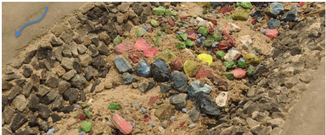
Abbildung 75: Stufe Nr. 4 nach Reparatur der oberen Blockreihe und des Erosionsschutzes oberhalb.
