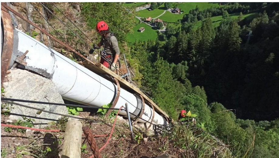
Fluhleitung ohne Schutzverkleidung
