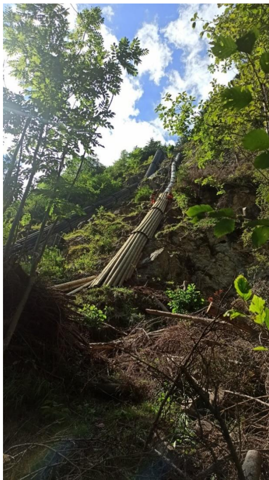
Montage neue Schutzverkleidung
