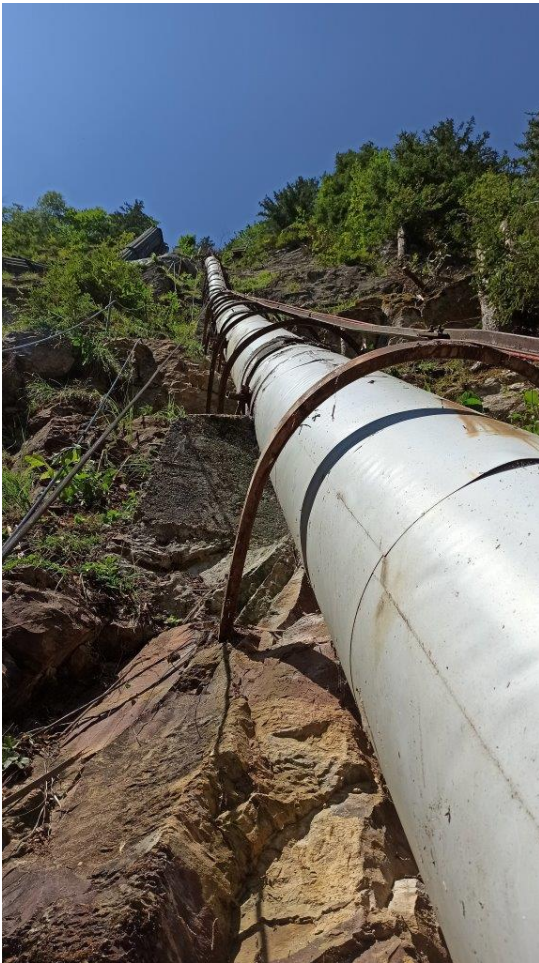
Fluhleitung ohne Schutzverkleidung
