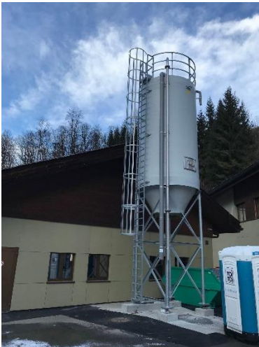
Kalksilo im Bau
