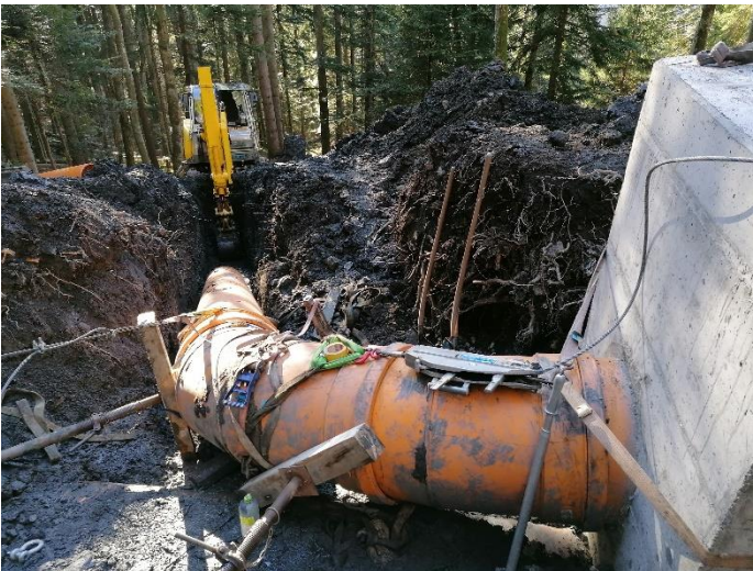
Hochwasserentlastung Chriechenbach, W1
