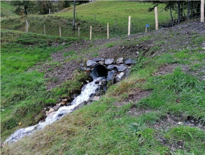
Bachdurchlass Brunnibach, W13
