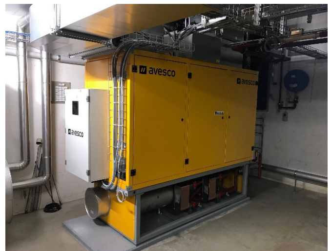
Rückbau vom alten BHKW
