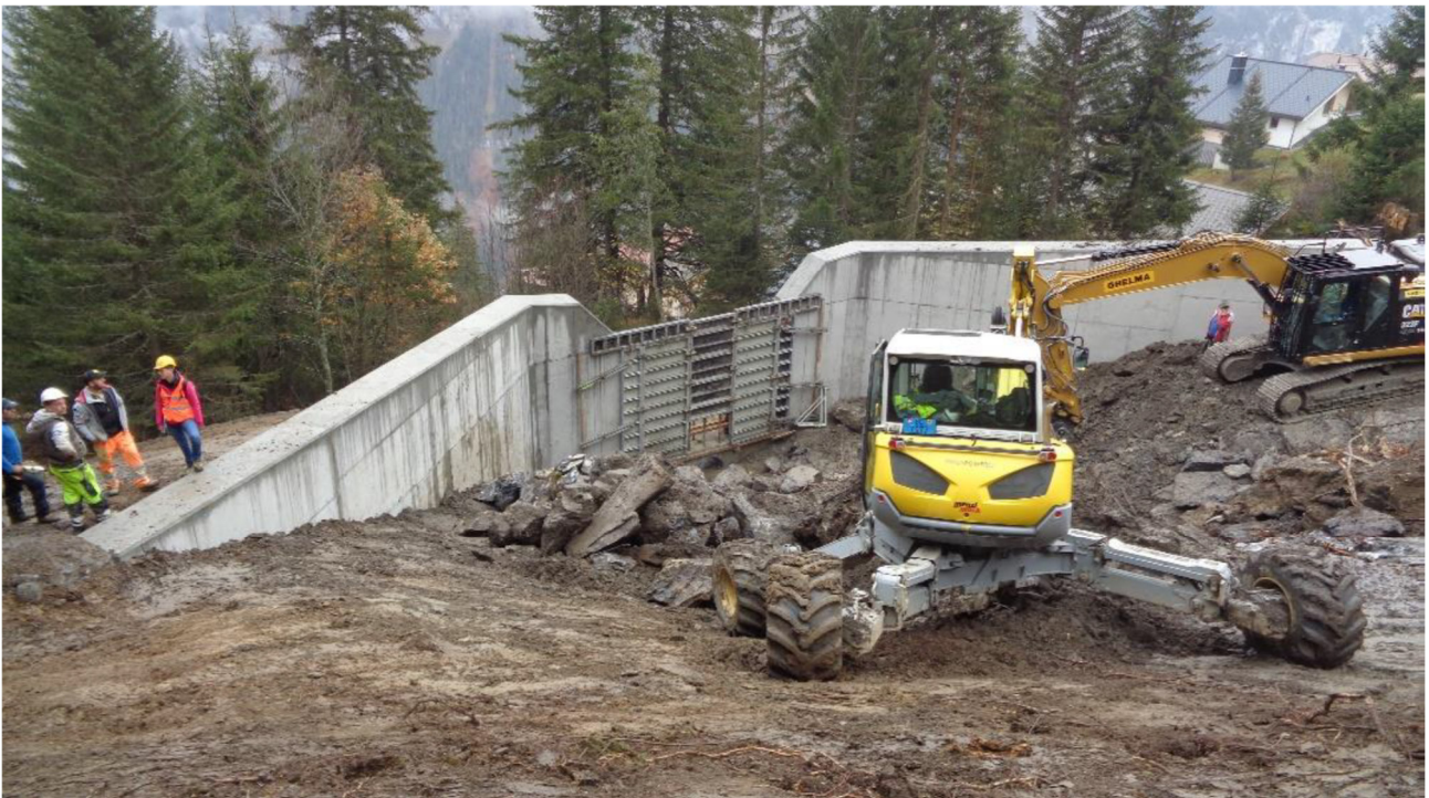
Geschiebesammler (Aushub Rückhalteraum in Arbeit)
