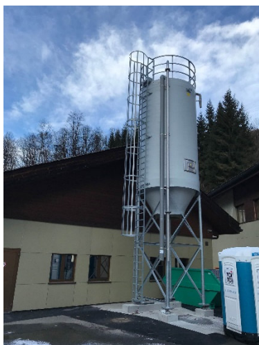
Kalksilo im Bau
