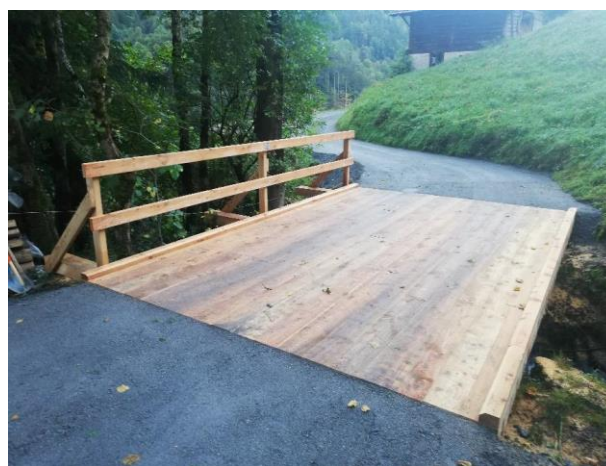
Neu erstellte Brücke
