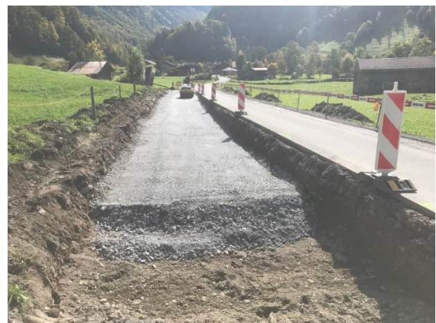
Absenkung der Gemeindestrasse mit neuem Strassenaufbau
