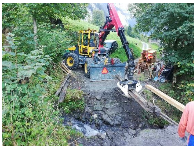
Ausbau alte Brücke
