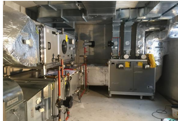
Installation der neuen Lüftungsanlagen
