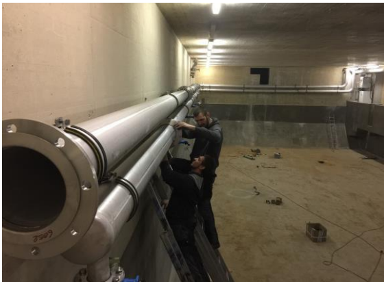
Montage der Prozessluftleitungen
