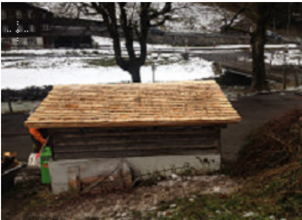
Schindeldach im Loch, Lauterbrunnen
