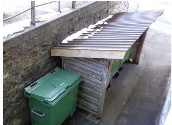
Blechdach Altes Schulhaus, Lauterbrunnen
