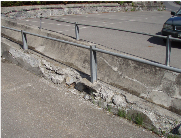
Mauer vor Sanierung
