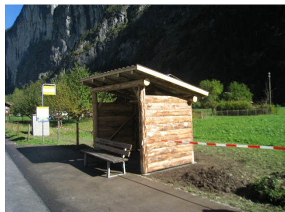
Wartehaus Postauto im Sandbach
