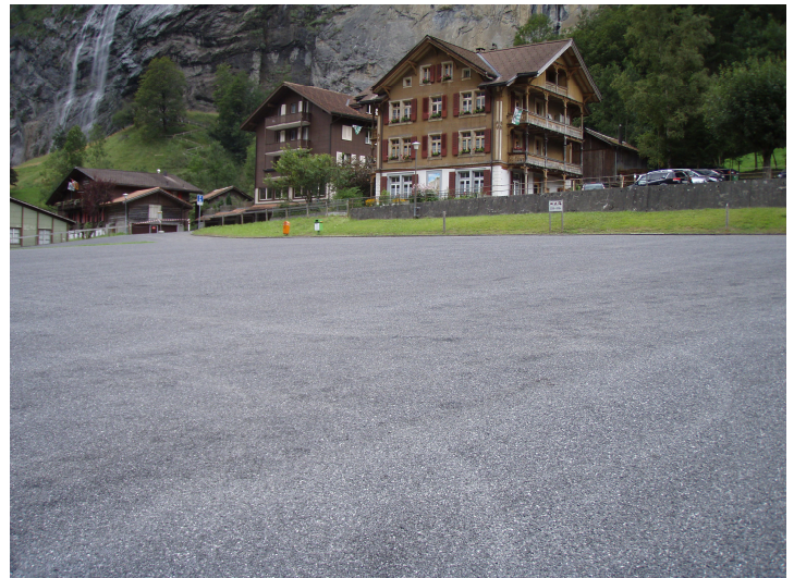
Platz nach Sanierung
