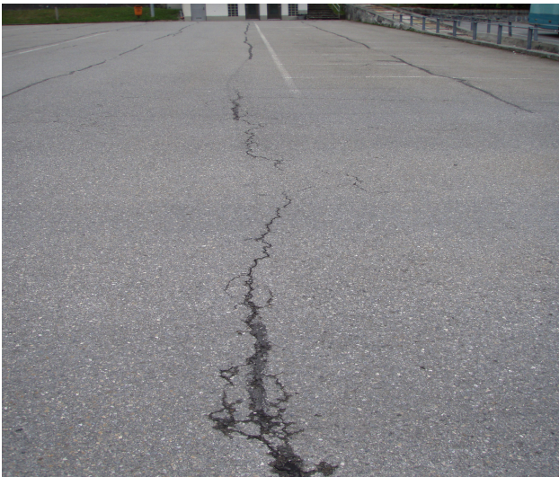
Platz vor Sanierung
