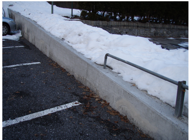
Mauer nach Sanierung
