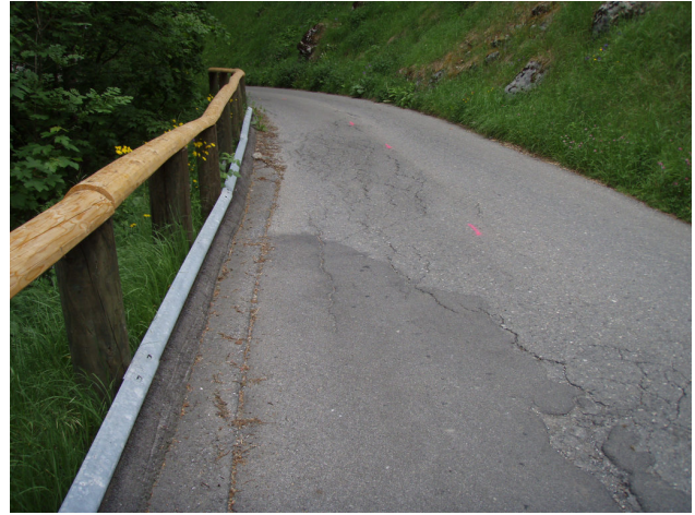
Isenfluhstrasse vor Sanierung
