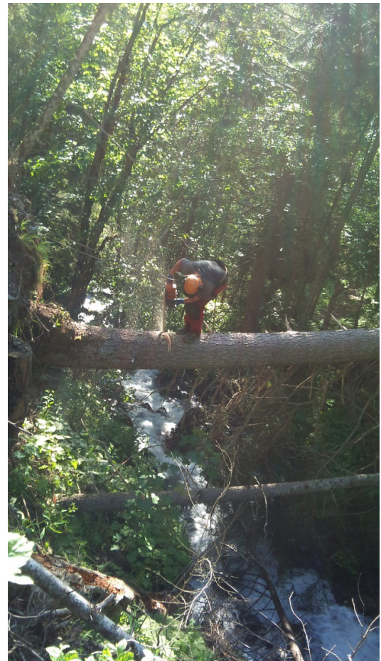
Vorbereitung für eine Sprengung Spezialfall am Staubbach (Bereich Lo-sisegg)
