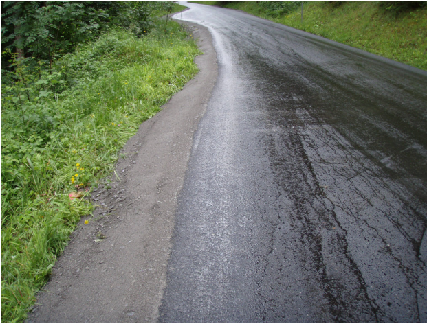
Isenfluhstrasse nach Sanierung
