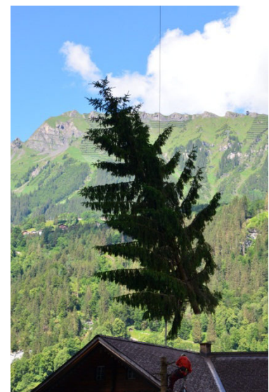
Spezialholzerei beim alten Schulhaus
