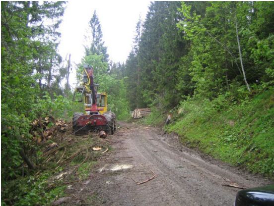
Forstspeziialschlepper, Flury, Holzschepf
