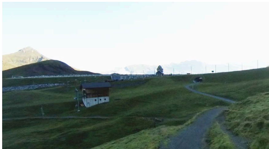
Abb. 1 Zwischen der Bergstation (Vordergrund, Links) und der Bahn-Unterführung (Hintergrund, Rechts) ist ein Gefälle von ca. 17% auf ca. 70 m Distanz zu überwinden
