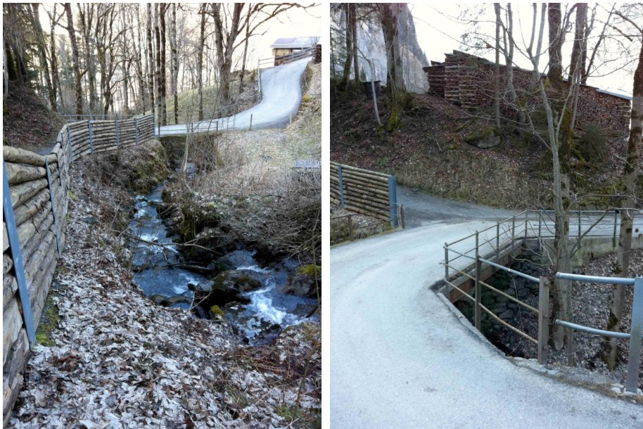
Abbildung 5: Holzpalisade bei der Brücke Stockiweg in Fließrichtung links
