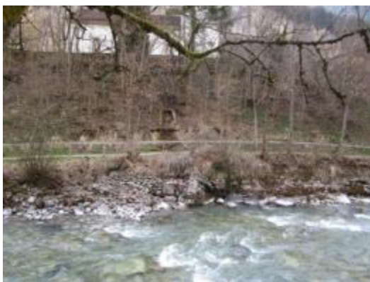
Abbildung 8: Holzkastenverbau unterhalb der Kirche
