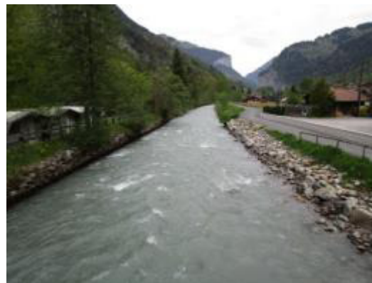
Abbildung 15: Blick in Fließrichtung zum Beginn des Projektperimeters. Monotone, eingengte Gerinneführung.
